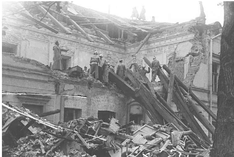
Вид разрушенного здания МК РКП(б)
